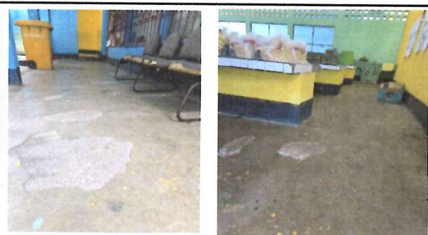
Foto 3: SUSTITUCION DE PISO DE CONCRETO EN MAL ESTADO POR PISO CERAMICO ANTIDELIZANTE
