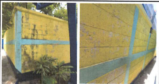
Foto 1: PINTURA EN MUROS EN MAL ESTADO
