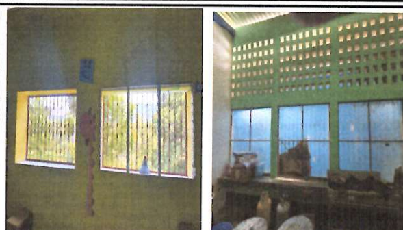
Foto 2: SUSTITUCIÓN DE VENTANAS POR VENTANAS CORREDIZAS DE PVC
