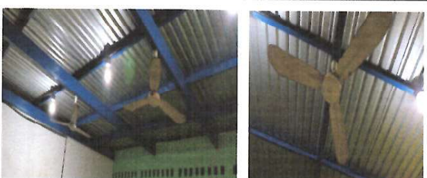
Foto 5: SUSTITUCION DE VENTILADORES
